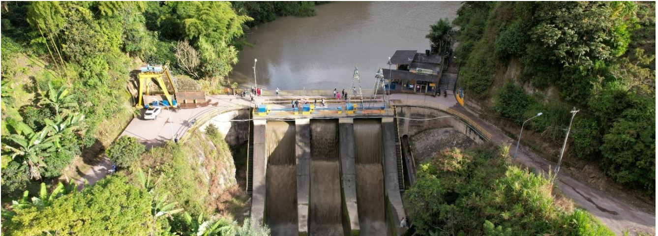
Pequeña Central Hidroeléctrica de Río Mayo
